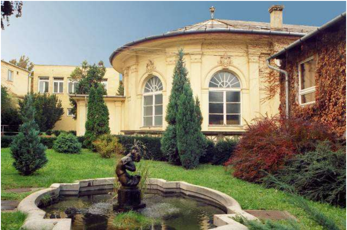
A mai 3-as épület előtti udvar
